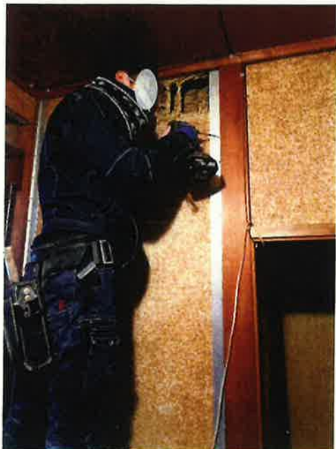
低コスト工法で施工中の補強箇所
