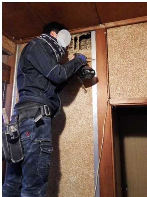
低コスト工法で施工中の補強箇所
